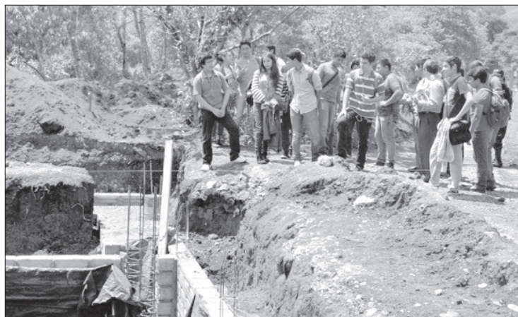
Los jóvenes constataron los trabajos
